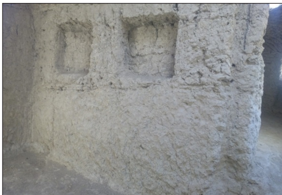
تصویر ۳۲. دیوار چینهای در خانه شماره ۷ (زمستان ۱۳۹۵).
