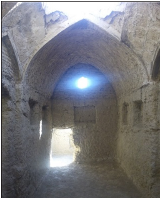
تصویر ۳۳. اجرای طاق بر روی دیوار چینهای در خانه شماره ۷ (زمستان ۱۳۹۵).
