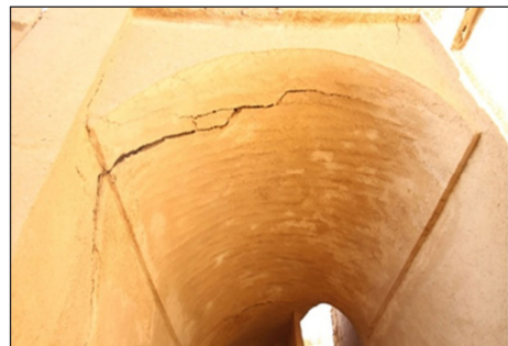
تصویر ۱۸. ترک در امتداد بندهای ملات‌خور طاق آهنگ در خانه شماره ۹ (پاییز ۱۳۹۴).
