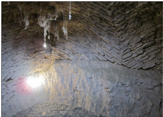
تصویر ۳۱. طاق چینی بر روی دیوارهای دست‌کند در خانه شماره ۳ (پاییز ۱۳۹۴).
