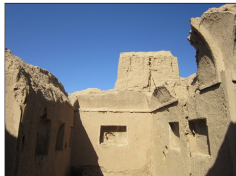
تصویر ۱۶. تخریب طاق آهنگ بر اثر رانش پاکارها در خانه شماره ۲ (زمستان ۱۳۹۵).
