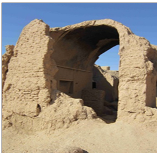
تصویر ۱۴. شکست خارج از صفحه دیوار و ریزش طاق در خانه شماره ۳ (پاییز ۱۳۹۴).
