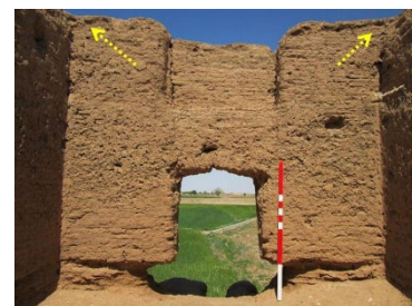
شکل ۱۶. نحوه گوشه‌سازی گنبد بر فراز مزار دستگردان (Authors, 2018)
