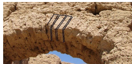
شکل ۱۲. نحوه تاق‌زنی به شیوه رومی درگاه ایوان‌ها، دستگردان (Authors, 2018)
