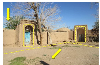
▲ تصویر ۲۳. حیاط‌های بیرونی و درونی قلعه فتح‌آباد و ایوان دار نمودن ورودی‌ها (نگارندگان، ۱۳۹۷).
