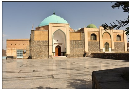
▲ تصویر شماره ۴. ایوان ورودی آرامگاه پیرحاجات بعد از مرمت - دید از شرق (نگارنده، ۱۳۹۷)
