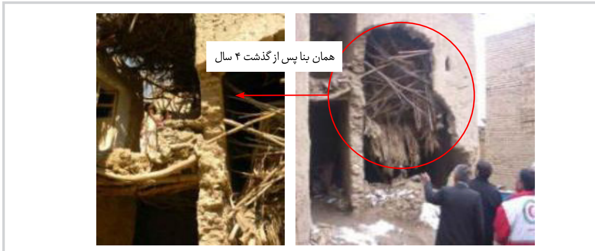
تصویر ۷: الف. تخریب سقف یک بنای مسکونی در برف سال ۱۳۸۵؛ ب. زندگی در مجاورت همان بنا در سال ۱۳۸۹
